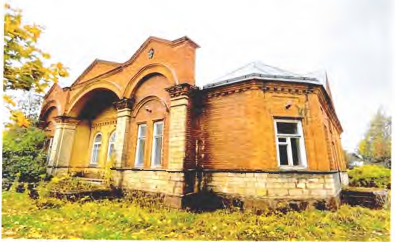
Фото 17. Вид с северо-востока. Назаренко Ю.Ю. 06.10.2022.
