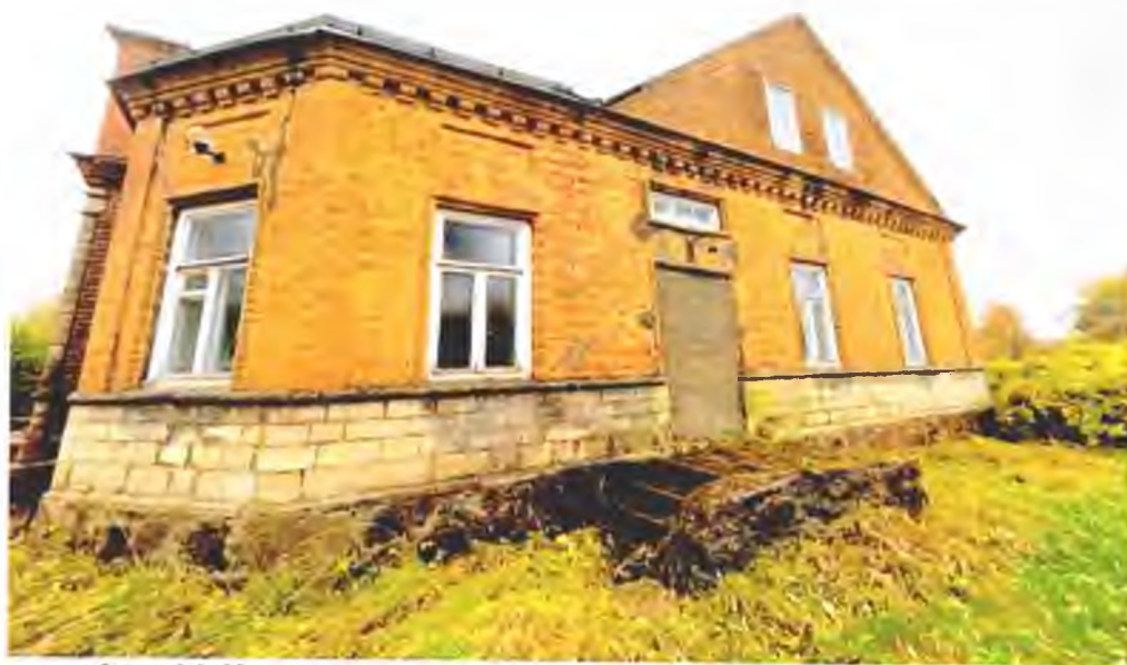
Фото 16. Крыльцо на северном фасаде. Назаренко Ю.Ю. 06.10.2022.
